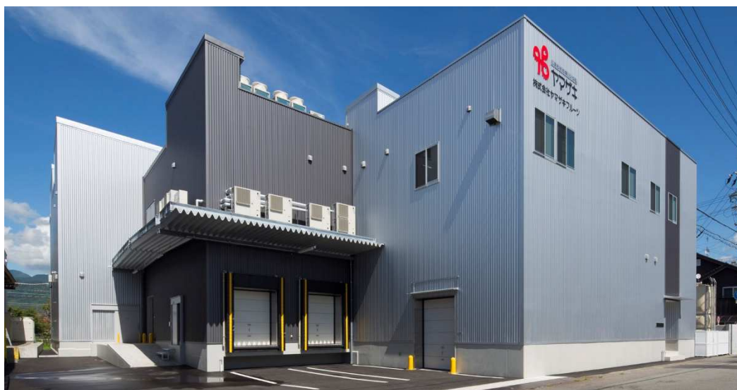
ヤマザキフルーツ清水袖師工場外観
